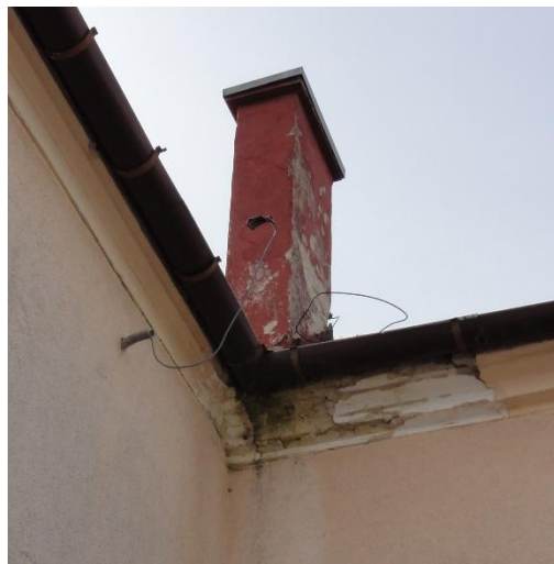
Fot. 6. Elewacja północna, ubytki gzymsu, rok 2024
