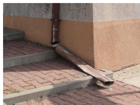
Fot. 4. Uszkodzenia odwodnienia, rok 2024
